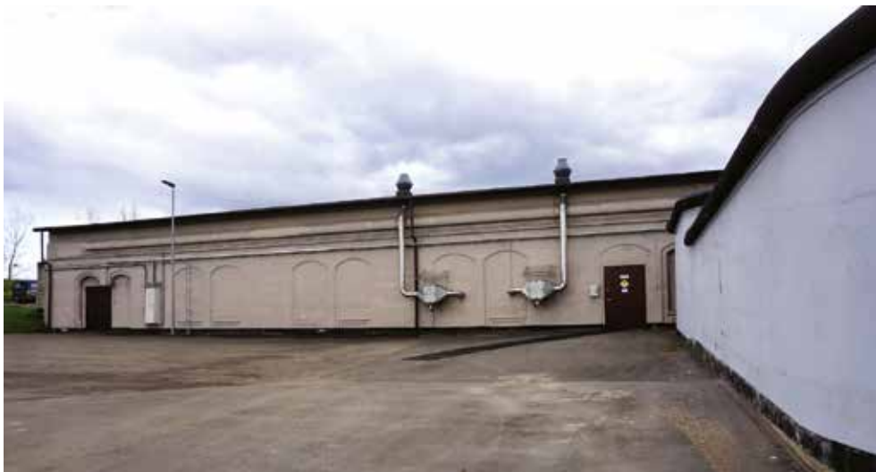
Widok ogólny frontowej ściany koszar sztyjowych fortu III w roku 2021. Od strony prawego barku widoczne jest nie zamurwane okno w latrynie. Na skrajach obu fotografii znajdują się ściany kaponier sztyjowej (fot. Z. Gołaszewski)
