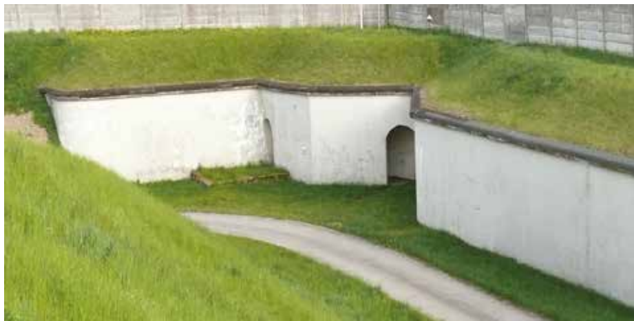
Podwójny kojec przeciwkarpowy fortu III (strzelnice zamurowane)
