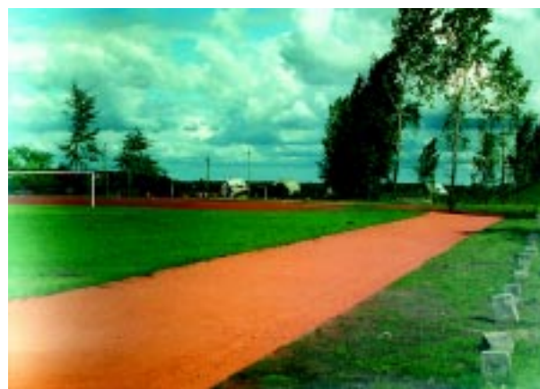
Remont stadionu. fot.Kruszewski
