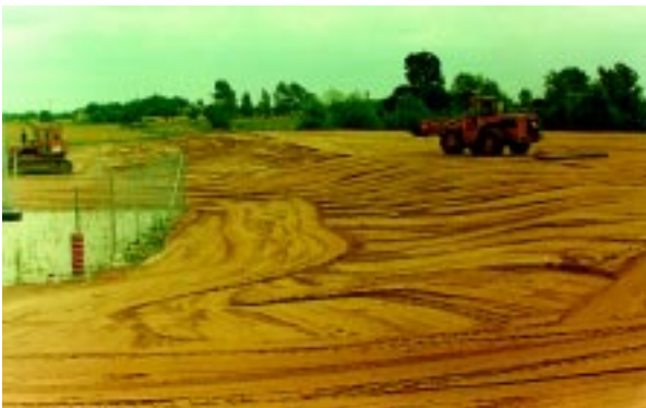
Prace przy rekultywacji starego wysypiska śmieci. fot. Kruszewski
