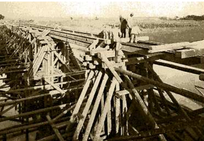
Budowa mostu kolejowego na Narwi pod Różanem; sierpień 1915 r.
