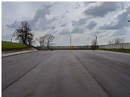
Fosa składowiska w Różanie. Powierzchnia zabezpieczona impregnującą warstwą bitumiczną. Fot.zuop.pl
