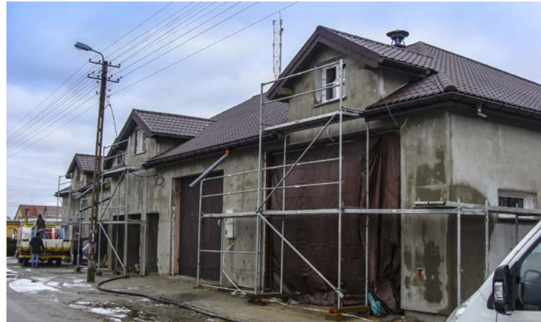
Remont remizy OSP w Załuziu.
