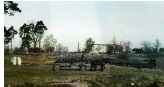
Kaszewiec - lata 60. W oddali jeden z niedokończonych przed 39 rokiem bloków oficerskich budowanych na terenie koszar, obecnie wykończony w zmienionej formie
