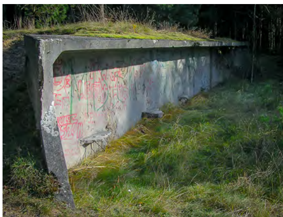
Kaszewiec 2010 r. - strzelnica. Schron betonowy dla czterech obserwatorów oceniających wyniki strzelań. Pozostały również widoczne na zdjęciu, uszkodzone miejsca do siedzenia
