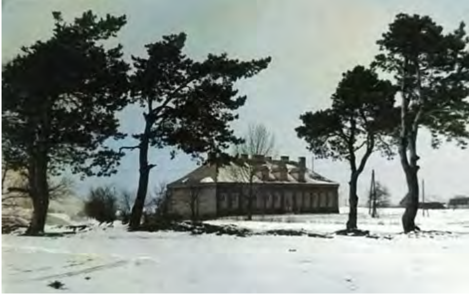
Lata 60. Przedwojenny budynek Poczty Polskiej. Widok do strony Narwi. Istnieje do dziś
