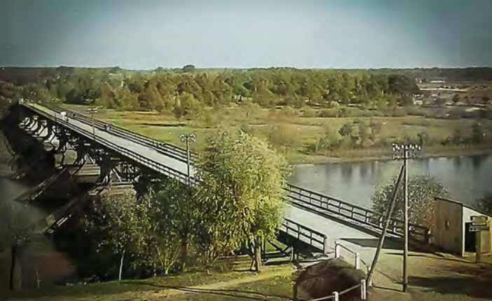
1932-1933 r. Most na Narwi między Różanem, a koszarami w Kaszewcu. Widok w kierunku Kaszewca
