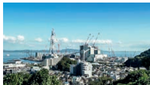
Elekrownia węgla budowana w Japonii
