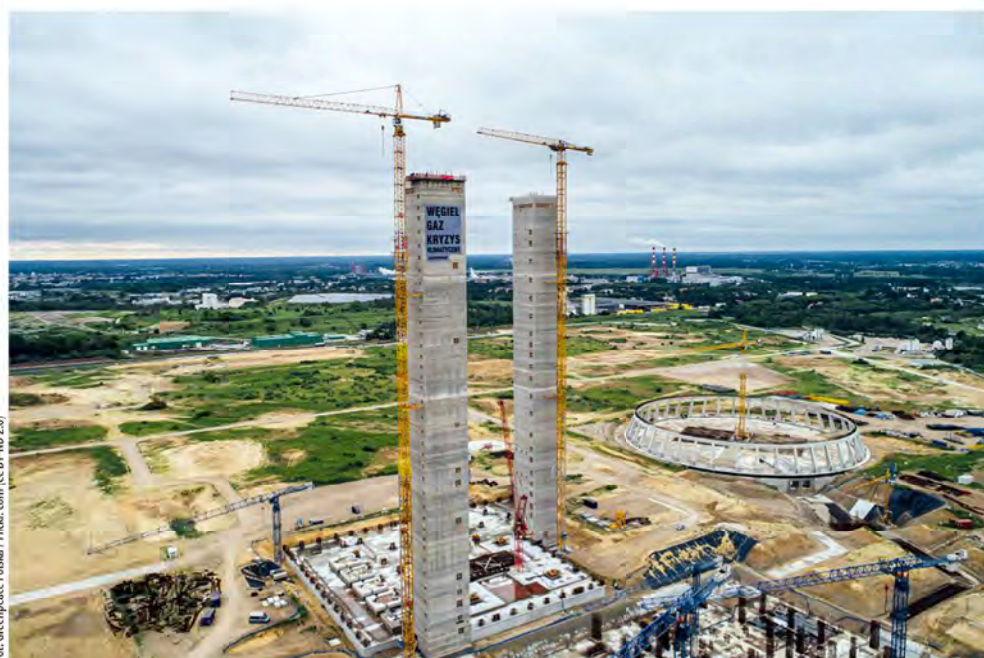
Na początku marca rozpoczęła się rozbiórka słynnych wież ostrołęckiej elektrowni. Spektakularny upadek inwestycji, która nigdy nie powinna się rozpocząć. Koszt jak dotychczas to niemal 1 mld zł. Zdjęcie z protestu Greenpeace w 2020 r.
