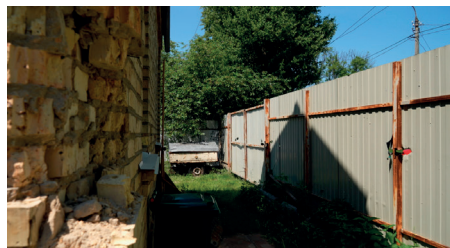
Podwórko Didkovskiego - w głębi przyczepa przy ogrodzeniu z której strzelał do cysterny.
