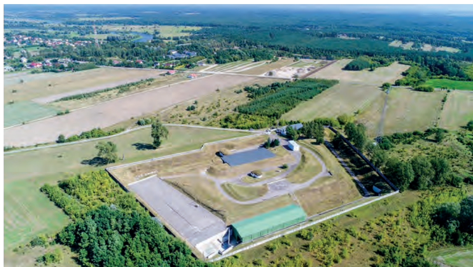
Widok Na Fort III - 2021 r. Obecnie Krajowe Składowisko Odpadów Promieniotwórczych
