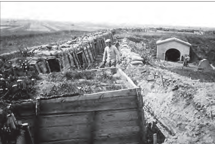
Wał główny fortu III po zajęciu przez Niemców w sierpniu 1915 r. Widoczny jest rów strzelecki z niszami przeciwdziałkowymi wkomponowany w linię ognia, w rejonie narożnika lewy bark—czoło (widok w oś czołowego odcinka wału). Ponadto w głębi po prawej stronie widać blok wejściowy do poterny (wjazd do schronu pogotowia dla uzbrojenia przeciwstrumowego, a niżej – wejście do przelotni przy magazynie amunicji). Poniżej obecny wygląd tego miejsca w roku 2021.
