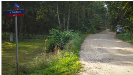
Przebudowa ulic Piaskowej, Świerkowej i Sosnowej we wsi Dąbrówka. Koszt 366 389,15 zł.
