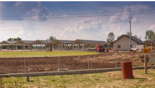
Budowa placu targowego. Wartość robót 3 948 249,63 zł. Termin wykonania do 31.10.2018 r.
