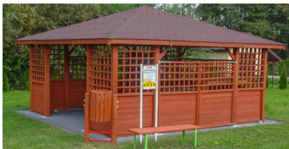
Altanka na placu przy świetlicy wiejskiej we wsi Załęże Wielkie. Koszt 14 760,00 zł.
