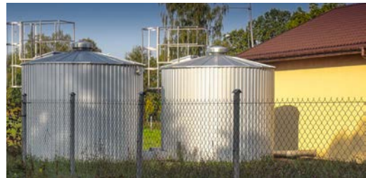
Rozbudowa stacji uzdatniania wody w Załężu-Sędziętach - budowa dwóch zbiorników retencyjnych.
