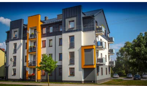
Budowa budynku mieszkalnego komunalnego. Wartość robót 2 283 522,38 zł. Ponad 700 tys. dofinansowania z BGK.
