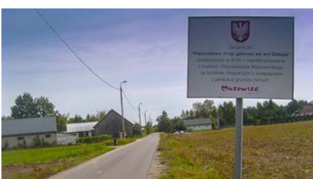
Przebudowa drogi gminnej we wsi Dzbądz. Wartość robót 146 969,07zł.
