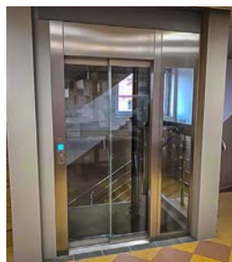
Budowa windy w budynku Urzędu Gminy. Wartość robót - 297 799,75 zł.
