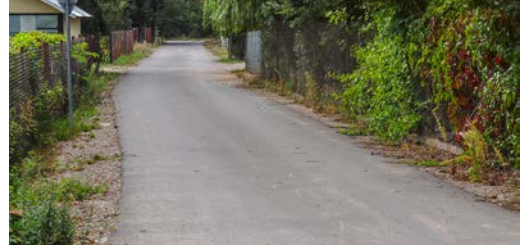
Przebudowa dróg gminnych w Podborzu. Wartość robót 671 496,86 zł.
