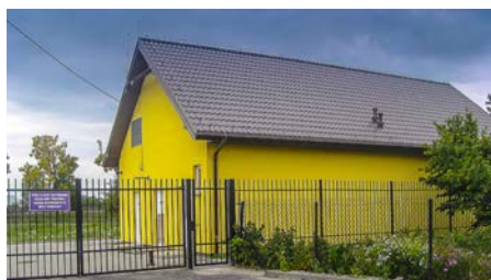
Budowa stacji uzdatniania wody w Różanie. Koszt budowy 2 099 760,10 zł. Uzyskano pomoc finansową w wysokości 1 192 616,00 zł.
