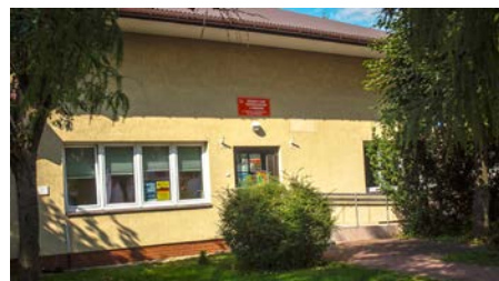
Remont i adaptacja pomieszczeń pod po- trzeby Dziennego Domu Senior-Wigor. Wartość robót 233 333,55 zł.
